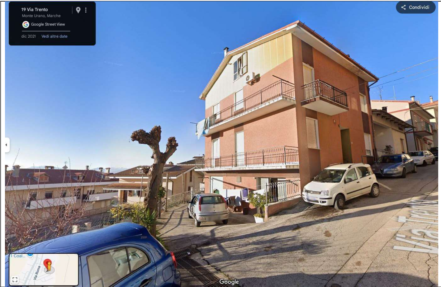
Immobile sito in Via Trento n.10
