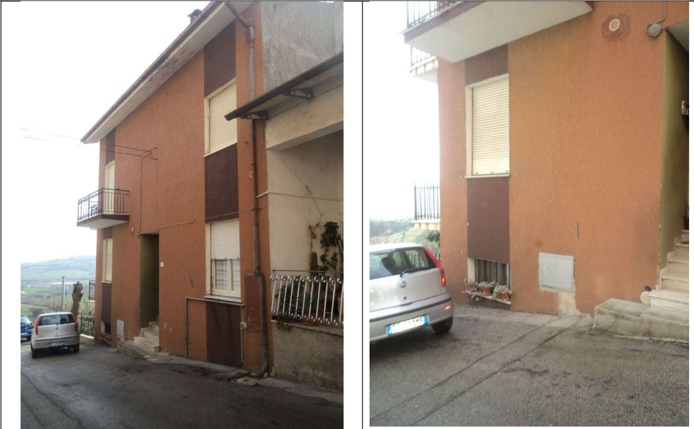
Immobile sito in Via Trento n.10
